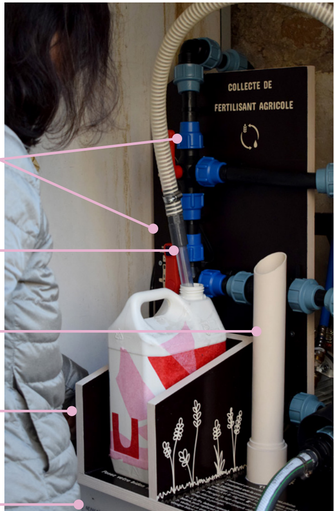
Station de transvasement au point d'apport volontaire d'urine.
