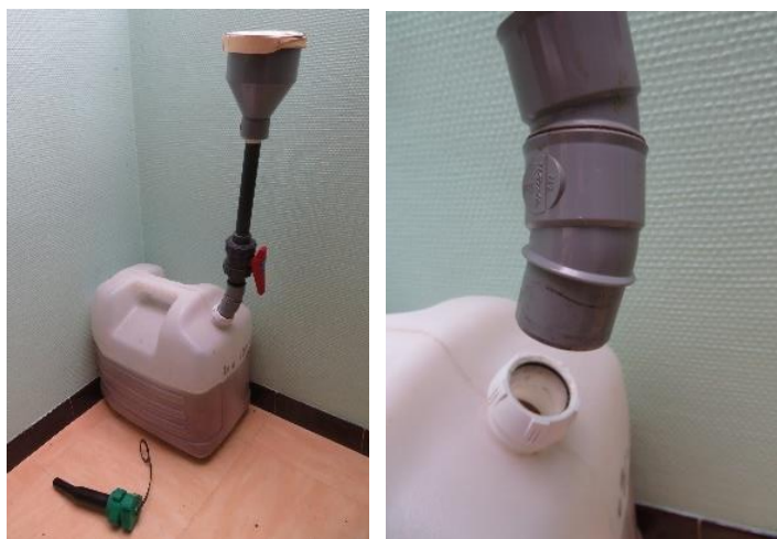
Figure 18: Couvercle boîte camembert en bois / Réduction PVC 100-40 / Tube PVC 40 collé / Vanne ( finalement inutile à l'usage) / Réducteurs et coudes 60° / Douille à visser sur bidon 20L. Source : témoignage RAE.
