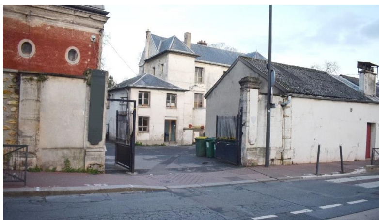
Figure 47 : Lieu de distribution des légumes de l'AMAP dans un bâtiment de la mairie, situé dans un parc qui ferme la nuit.
