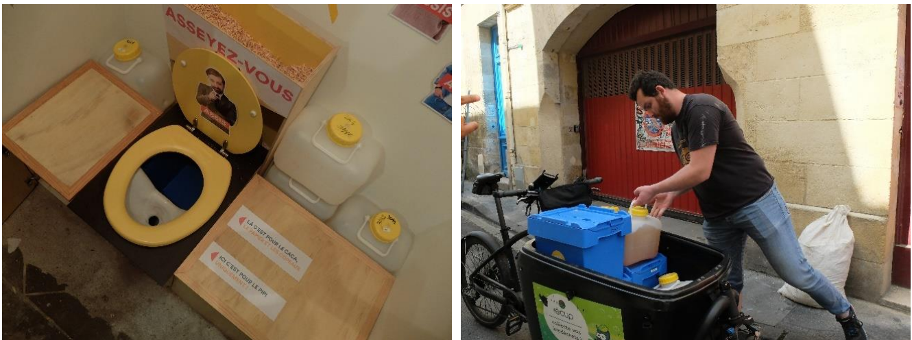
Figure 9 : A gauche, toilettes sèches à séparation d'urine, modèle Bibok, développé par Un Petit Coin de Paradis ; A droite, collecte en porte-à-porte des urines (bidons) et fèces (boîtes bleues) à l'aide d'un vélo triporteur.
