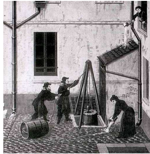
Figure 19 : Vidange d'une fosse mobile en 1820 (Bellanger 2010)
