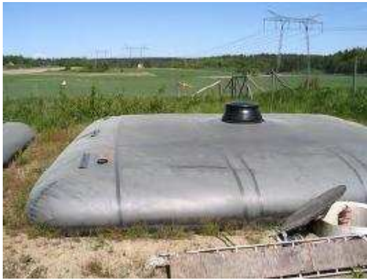
Figure 26 : Grande citerne de stockage de l'urine en Suède (EcoSanRes 2006)
