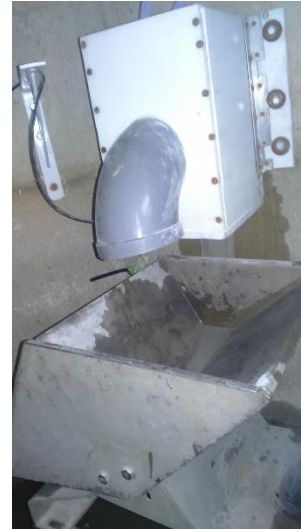
Figure 16 : Bac en téflon de récupération et de prélèvements des eaux drainées et augets basculants de 5 L
