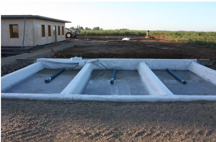
Figure 5 : Photographie des 3 places lysimétriques du parking perméable de Broué
