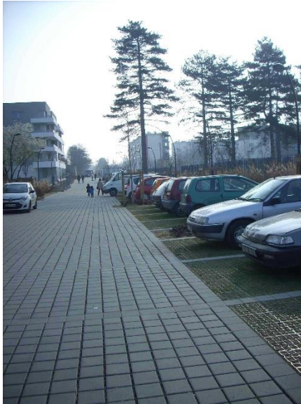
Figure 2 : Photographie du parking perméable végétalisé de Villeneuve-le-Roi
