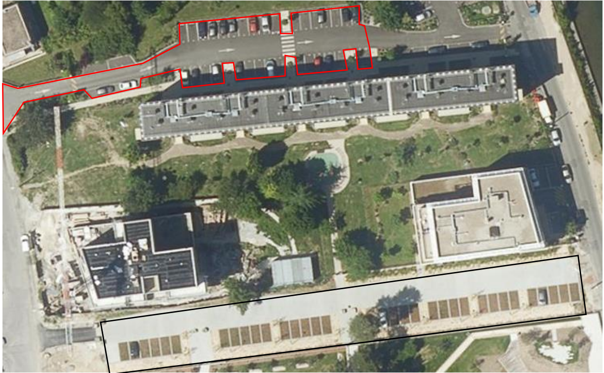
Figure 9 : Vue aérienne des parkings de Villeneuve-le-Roi. En noir, les contours du parking perméable, en rouge, les contours du parking traditionnel.
