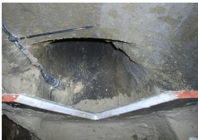
Figure 12 : Photographie du déversoir triangulaire avec mesure de la hauteur d'eau
