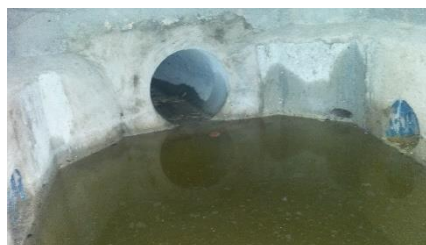
Figure 8 : Regard d'arrivée des drains du parking perméable. A gauche et à droite l'arrivée des deux drains du parking. Au centre, la canalisation permettant l'évacuation du regard (Villeneuve-le-Roi, 2015, © Jacquiel)
