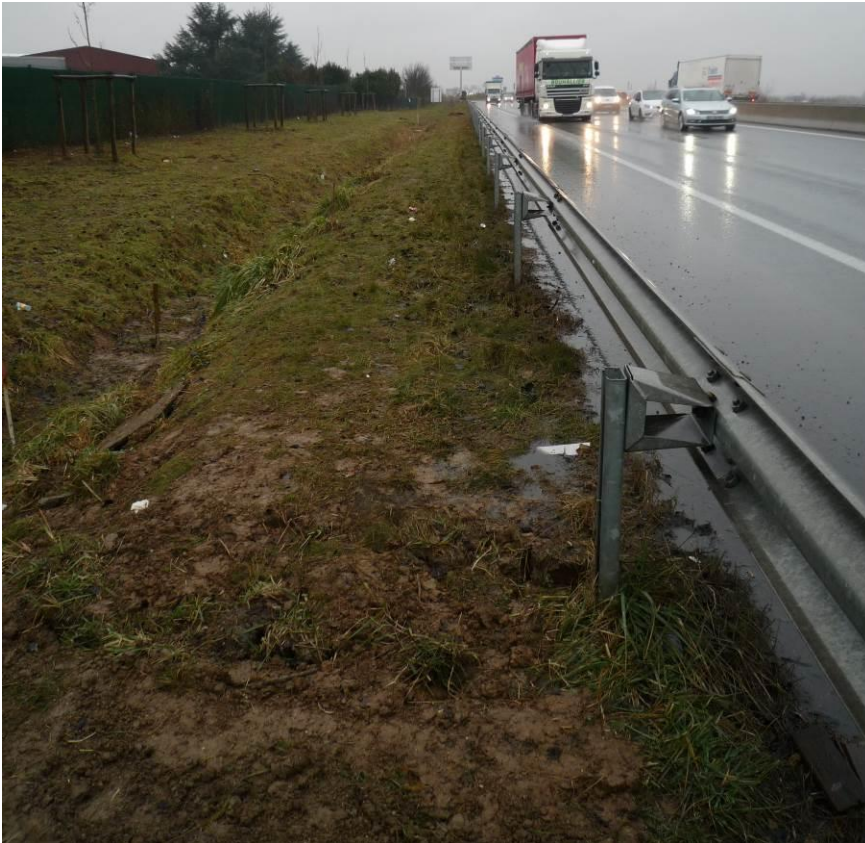
Image 1 : Photographie de l'ouvrage à Compans
