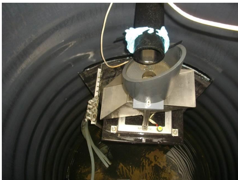
Image 12 : Système de fractionnement de l'eau dans la cuve de la noue
