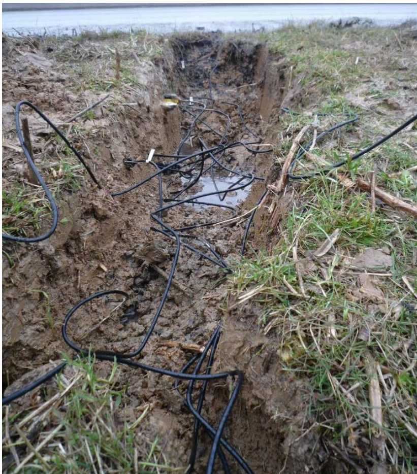
Image 9 : Installation de capteurs hydrologiques sur l'accotement du bief 2
