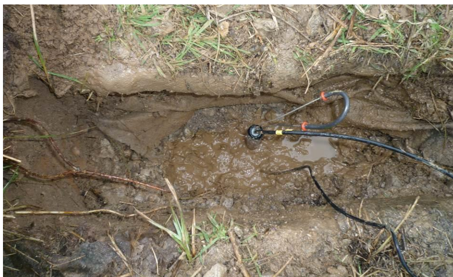
Image 10 : Installation de tensiomètre T8 sous le fossé du bief 2
