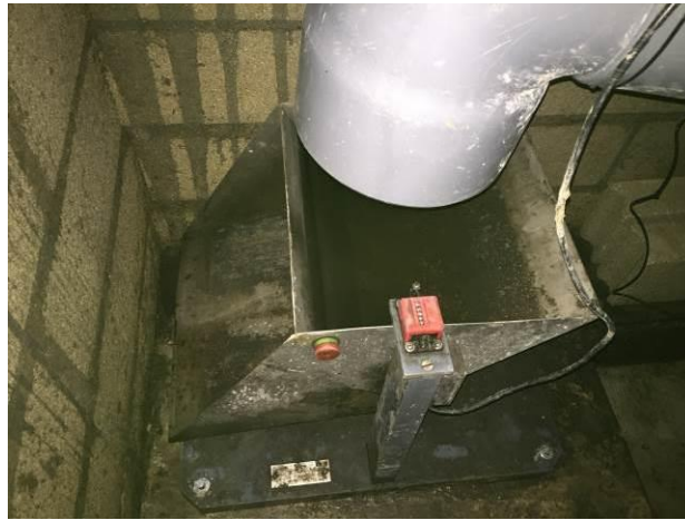
Image 7: Auget basculant du regard eau brute
