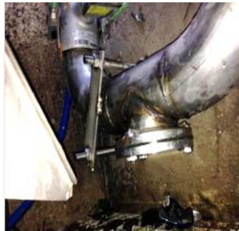
**Figure 13-** Vue du siphon, de l'insertion de la sonde NIVUS dans le siphon (à gauche), vue du dispositif permettant de vider le siphon (à droite)
