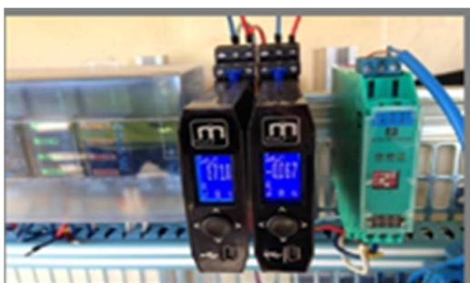
**Figure 21** – Affichage du niveau d'eau dans le STOPPOL® mesuré par la sonde piézométrique
