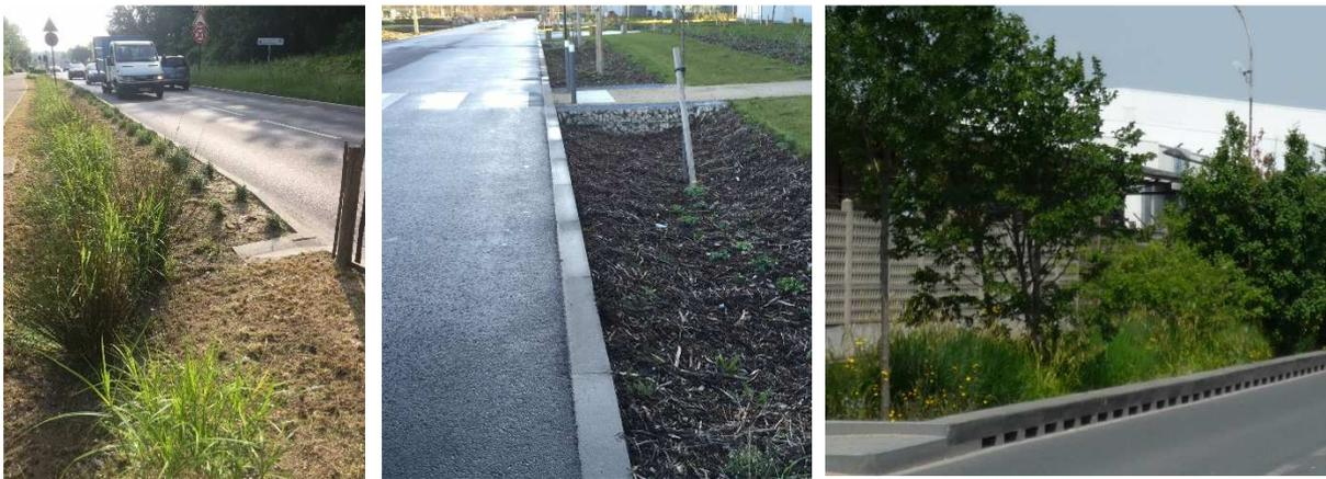
Figure 102 : Exemples d'alimentation en eau de noues à en proximité immédiate de la route, aménagements respectivement situés à Torcy, à Montévrain et à Vitry (Gromaire, 2018a)
