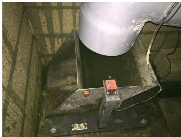
Figure 39 : Auget basculant du regard des eaux brutes
