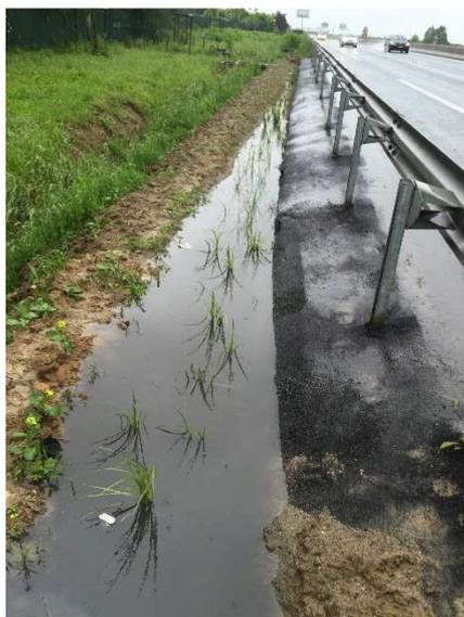
**Figure 34 : La noue filtrante rempli d'eau avant la pose des redans en Mai 2016; l'eau déborde en aval de l'ouvrage, alors qu'il n'y a pas de stockage sur la partie amont.**
