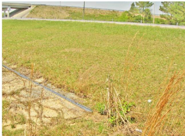
Figure 2 : Bande enherbée au bord d'une autoroute (Winston et al., 2012)
