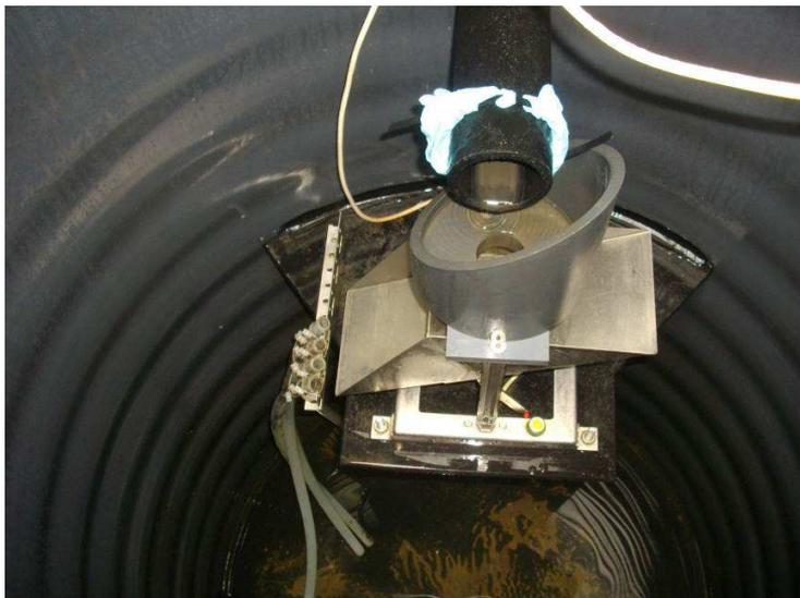
Figure 44 : Système de fractionnement de l'eau dans la cuve de la noue filtrante
