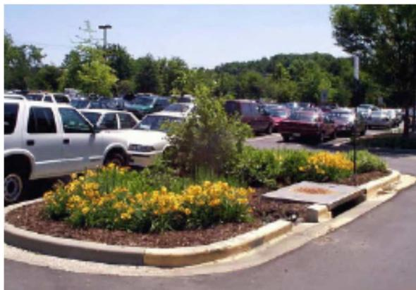
Figure 5: Système de biorétention (Clar et al., 2004)
